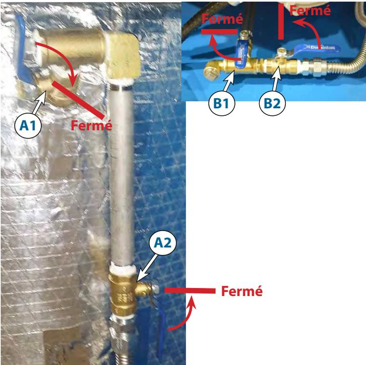
1. Fermer les 4 valves à bille au niveau de la bouilloire [A1] [A2] et en bas [B1] [B2]
